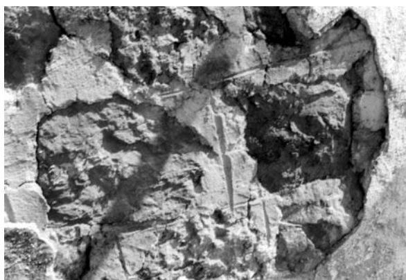
Sl. 4.15: Mali grad, kapela, podrobnost zidave zidu 3 iz delno obdelanih peščenjakovih lomljencev v tehniki plastene zidave s črtnim fugiranjem (dokumentacija ZVKDS, OE Kranj, fotografija N. Leben).
