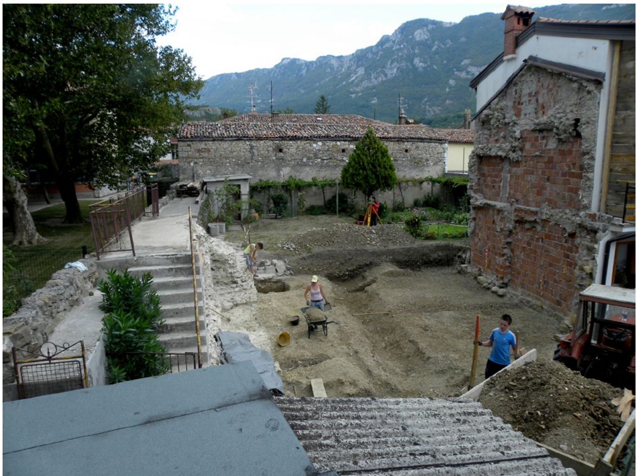
Slika 9 Pogled z juga na izkopišče. Levo ga je zamejevalo deloma rekonstruirano obzidje Kastre, desno pa hiša Šibeniška 11. Meje izkopišča so v grobem sovpadale z obsegom maja 2011 porušene stare hiše (foto T. Fabec).
